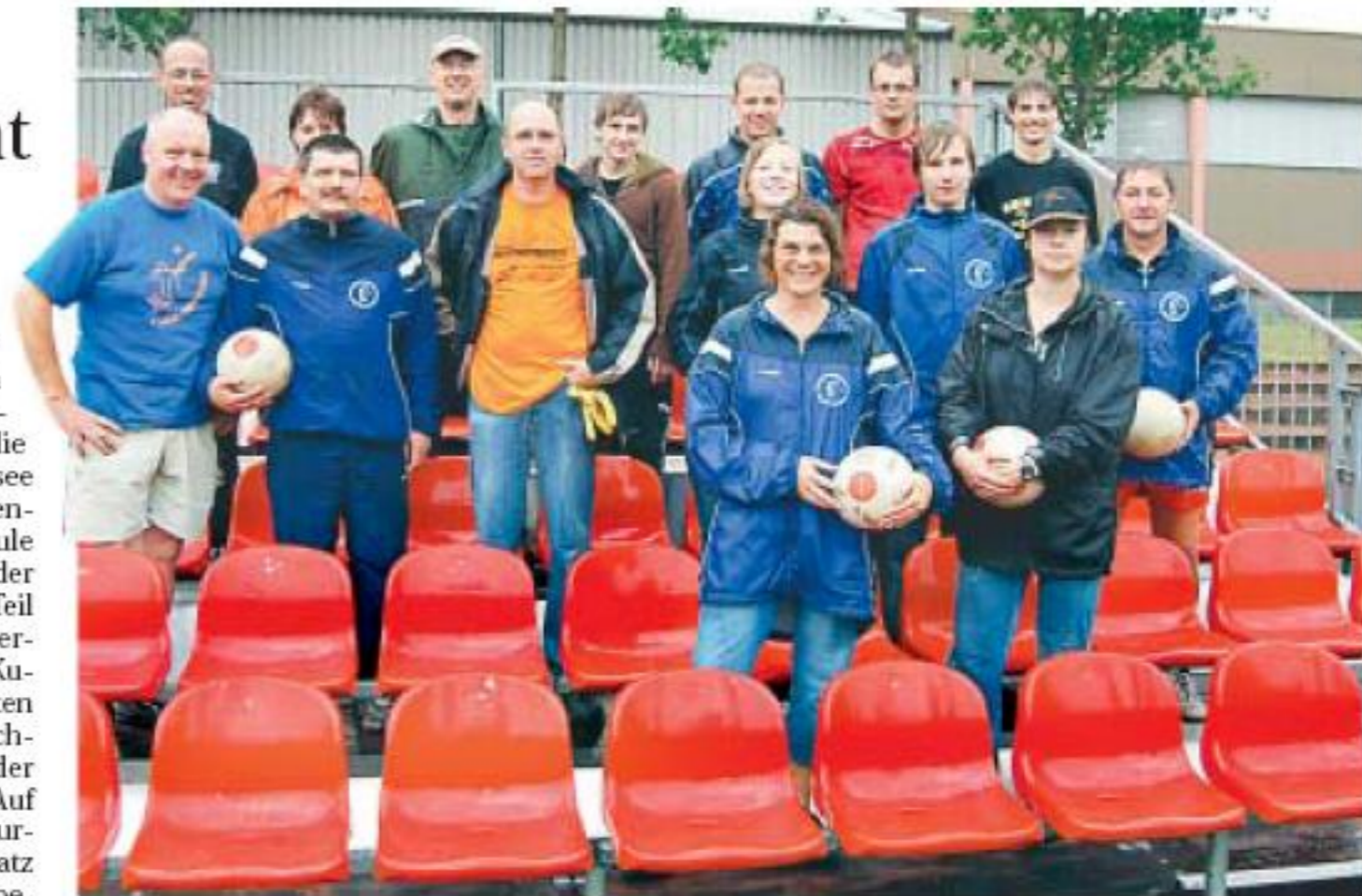
Die Helfer des WTV ließen sich am Dienstagabend auch nicht vom kräftigen Regen vom Aufbau der Zuschauertribüne für die Faustballmeisterschaft abhalten. BILD: FA DEM RECHT
